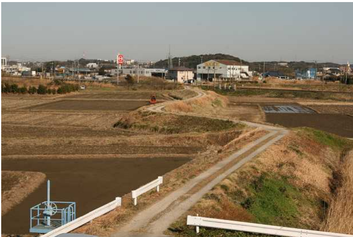
写真 2月8日撮影 屈曲のため洪水時の流れが乱れ、堤防に悪影響を及ぼすと思われる
