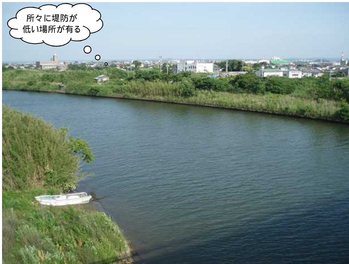
写真 2月8日撮影 屈曲のため洪水時の流れが乱れ、堤防に悪影響を及ぼすと思われる
